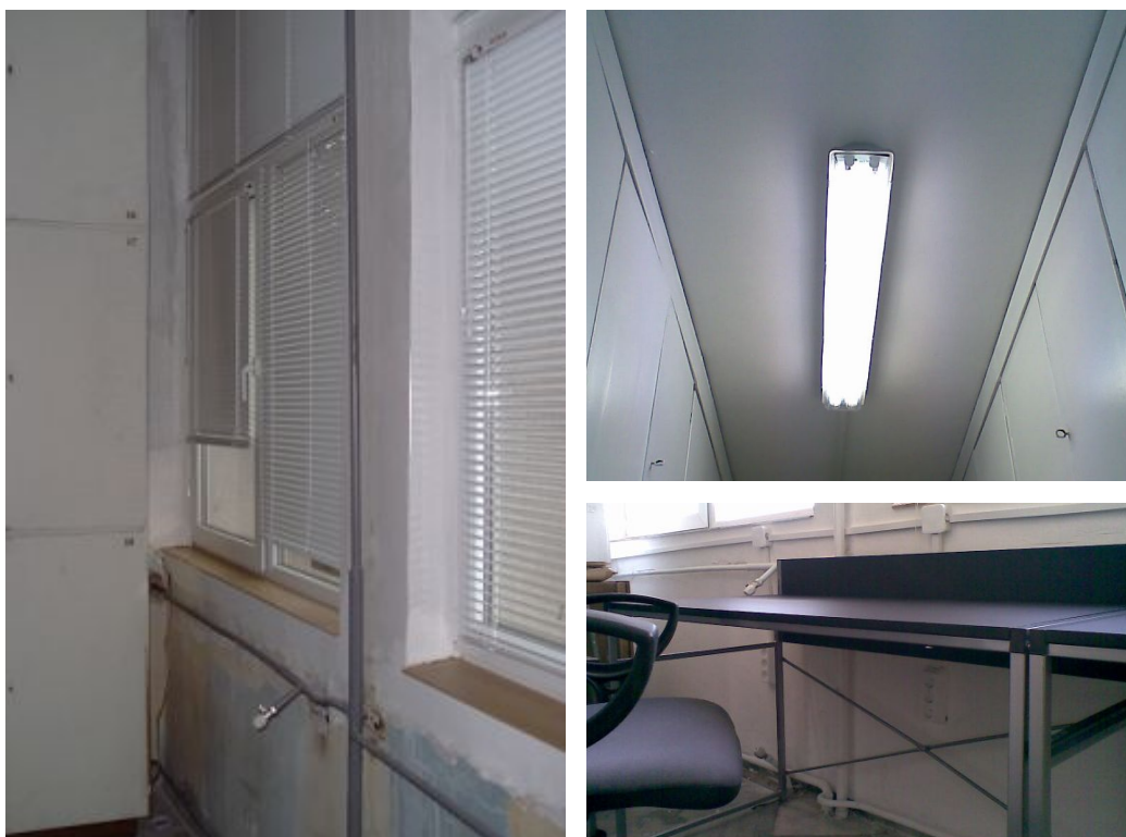
Фиг. 1. Зала I – интериорна скица, снимки преди ремонта и след монтирането на електрическата инсталация
